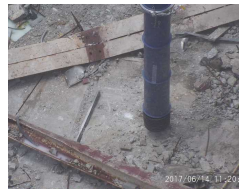
吸引機によるガレキ撤去の様子（1号機）
