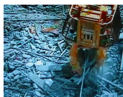
フォークによるガレキ撤去（3号機）の様子
