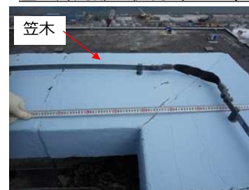
屋上外周部の状況 (その2)
