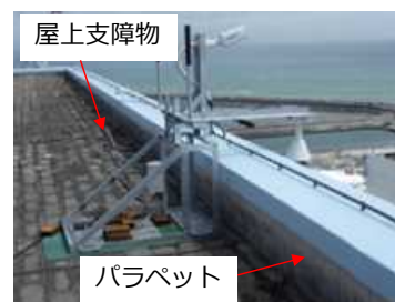
屋上外周部の状況 (その1)
