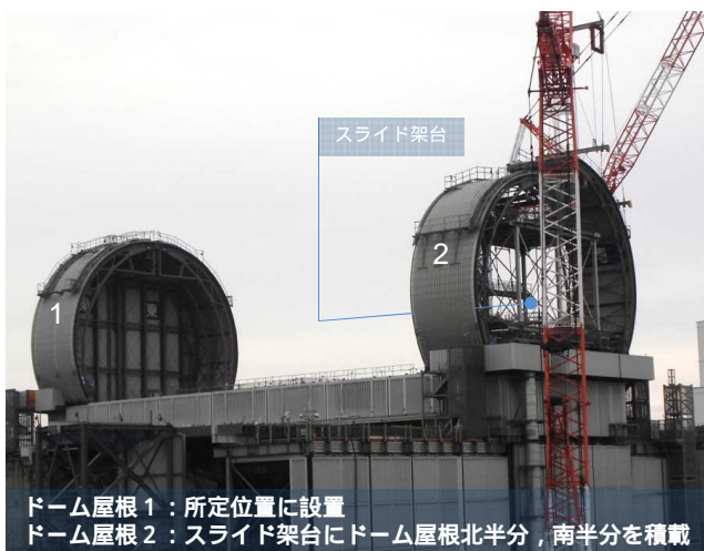
ドーム屋根設置状況 (撮影日：2017年9月6日)
