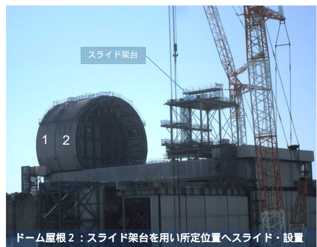
ドーム屋根設置状況 (撮影日：2017年9月26日)
