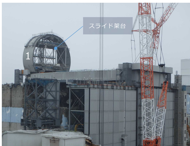
3号機原子炉建屋オペフロ全景
