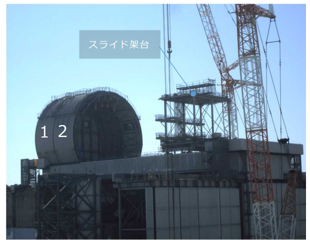
3号機原子炉建屋オペフロ全景
