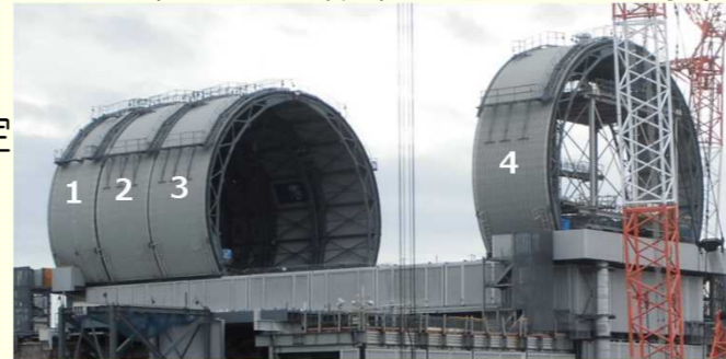
<ドーム屋根設置状況(10/25撮影)>
