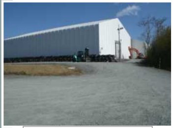
瓦礫保管テント
