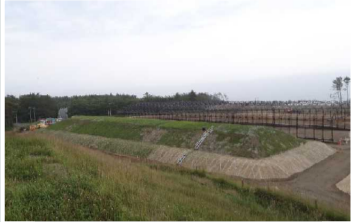
覆土式一時保管施設
