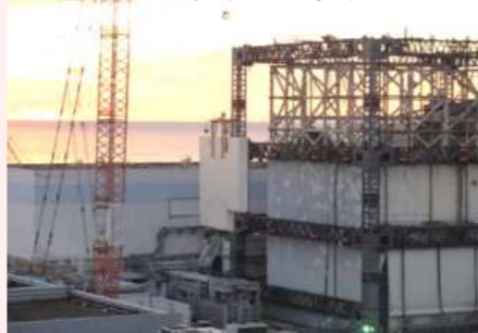
<壁パネル取り外し状況>
