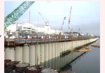
海側遮水壁 鋼管矢板打設完了状況
