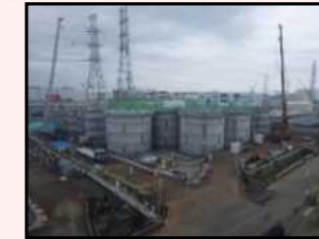
H1東エリア解体開始時の様子
