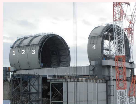
ドーム屋根設置状況(10/25撮影)
