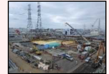
H1東エリア解体後の様子
