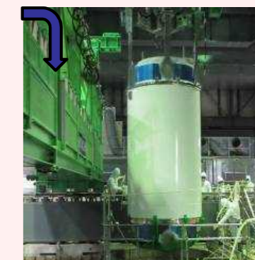
燃料取り出し状況
