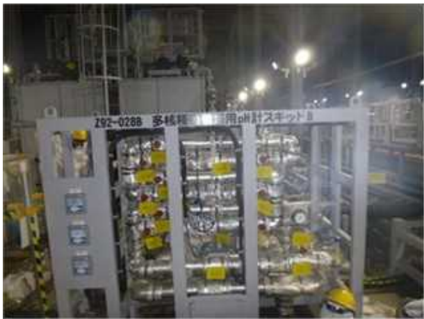
吸着塔用pHスキッド全景
