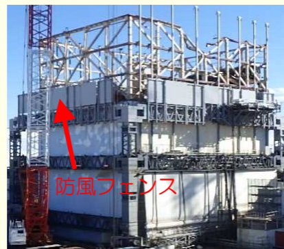
進捗状況（11/27撮影）
