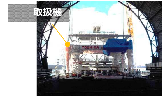
燃料取扱機、ガーダ上への設置状況 (撮影日2017年11月12日)
