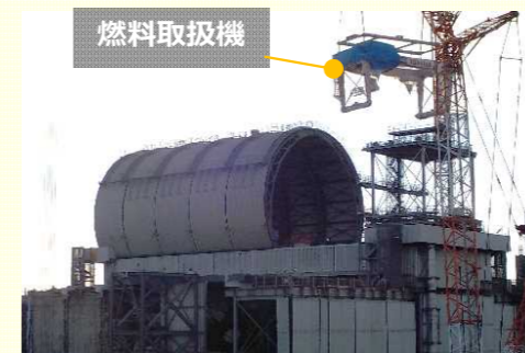
燃料取扱機の設置状況（撮影日2017年11月12日）
