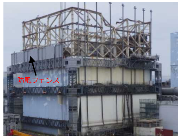
防風フェンス設置状況(11月9日撮影)
