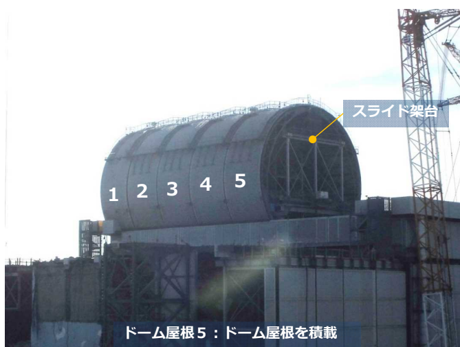
ドーム屋根設置状況 (撮影日2017年11月1日)
