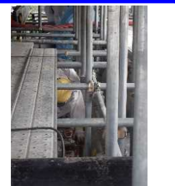
(凍結管バルブ開閉操作の様子)
