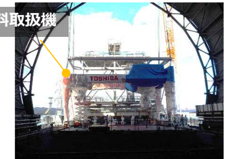
燃料取扱機、ガーダ上への設置状況 (撮影日2017年11月12日)
