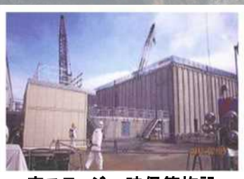
廃スラッジ一時保管施設
