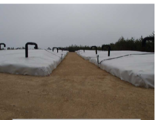
伐採木一時保管槽
