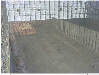
瓦礫保管 テント内
