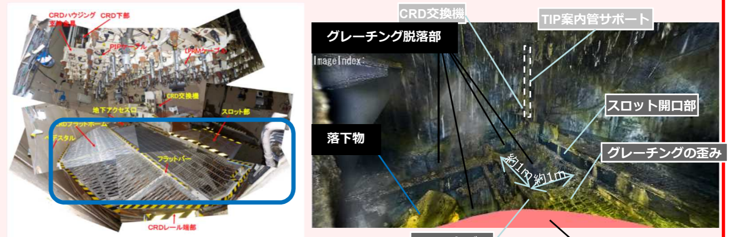
(参考) 5号機のペDESTAL内 ペDESTAL内部の状況
