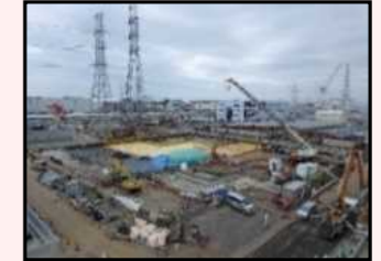
H1東エリア解体後の様子
