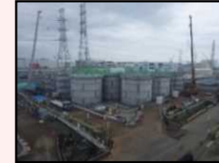
H1東エリア解体開始時の様子
