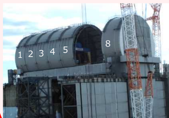
ドーム屋根設置状況(12/19撮影)
