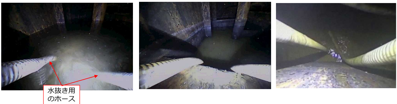
復水器H/W天板下部の水抜き作業（移送前）
