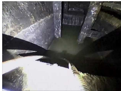
復水器H/W天板下部の水抜き作業（移送中）
