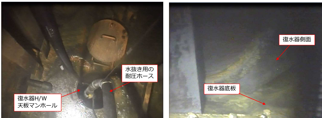
水抜き後の復水器底板の状況確認（視線方向②）
