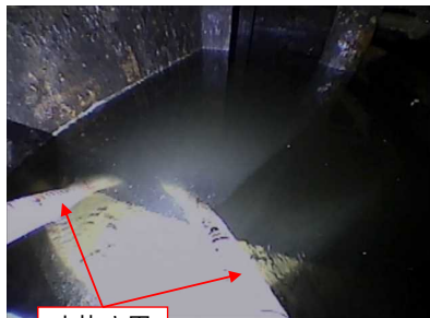
水抜き用のホース
