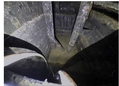
復水器H/W天板下部の水抜き作業（移送後）
