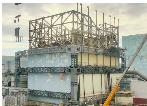
⑦【2017年10月31日：防風フェンス1枚目取り付け】
