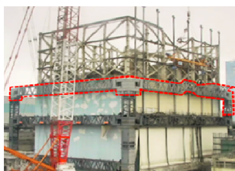
⑥【2017年10月24日：鉄骨改造・取り付け完了】
