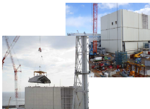
②【2015年10月5日：屋根パネル取り外し完了】
