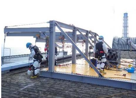
架台設置状況（原子炉建屋屋上）
