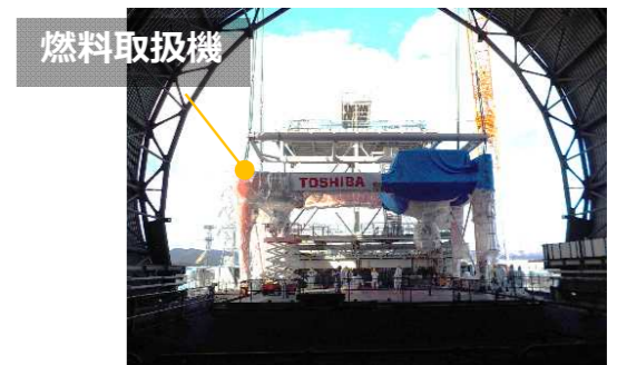
燃料取扱機、ガーダ上への設置状況 (撮影日2017年11月12日)
