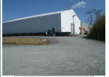
瓦礫保管テント
