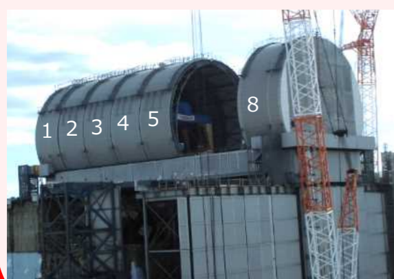
ドーム屋根設置状況(12/19撮影)
