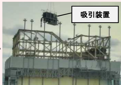
<進捗状況(1/22撮影)>
