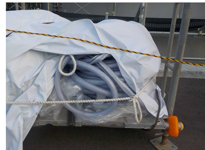
【漏えい2】 仮設ホース保管状況写真
