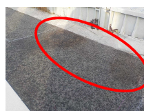
① G 3 北側 漏えい箇所 (仮設ホース端部漏えい)
