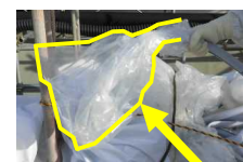
仮設ホース 袋養生
