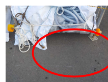
② G 4 北側 漏えい箇所 (資材ラック前)
