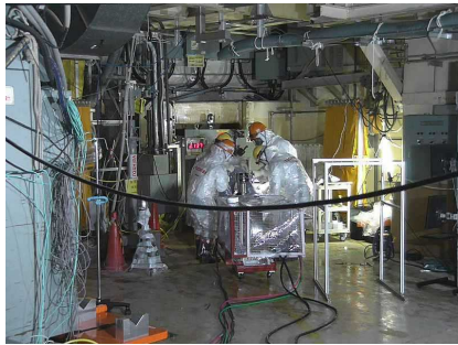
PCV外部（X-6ペネ）前での作業
