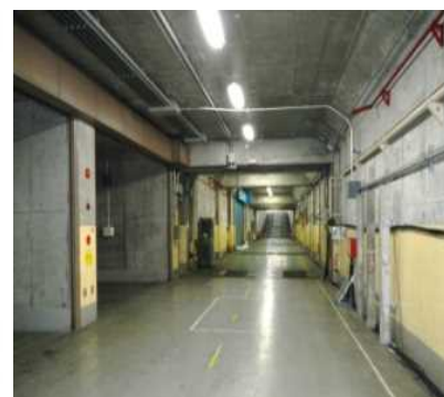
地下貯蔵庫通路
