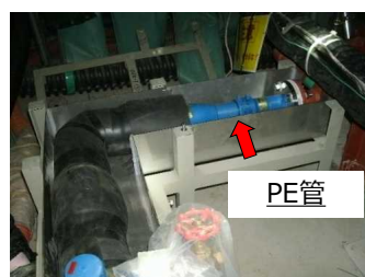
新規PE管施工後
