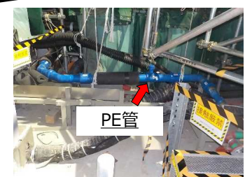
新規PE管施工後
