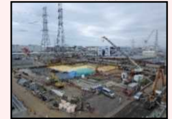
H1東エリア解体後の様子
