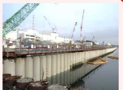
海側遮水壁 鋼管矢板打設完了状況
