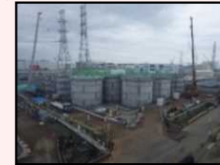
H1東エリア解体開始時の様子
