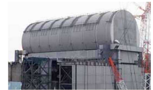
ドーム屋根設置状況 (撮影日2018年2月21日)
