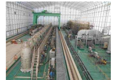
(高性能多核種除去設備)
