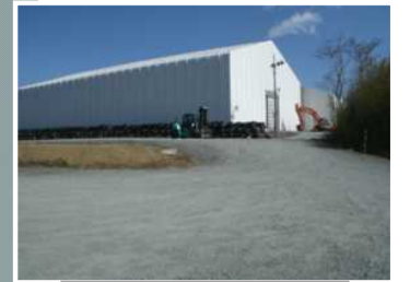
瓦礫保管テント
