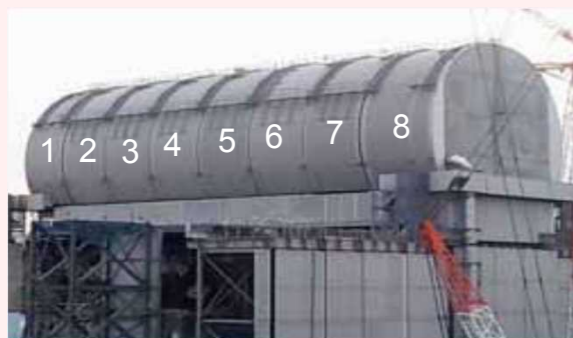
ドーム屋根設置状況(2/21撮影)
