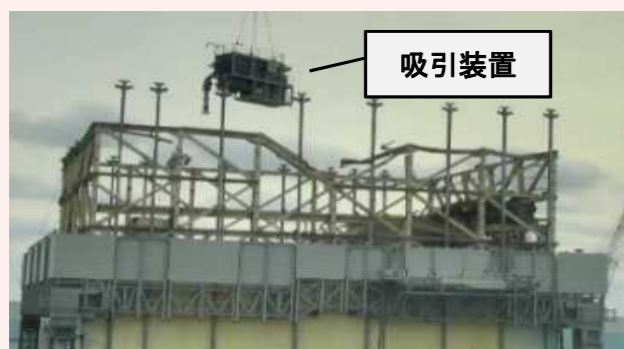
<進捗状況(1/22撮影)>
