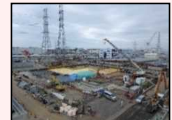
H1東エリア解体後の様子
