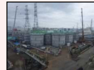
H1東エリア解体開始時の様子
