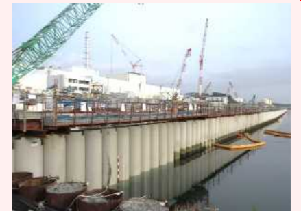
海側遮水壁 鋼管矢板打設完了状況
