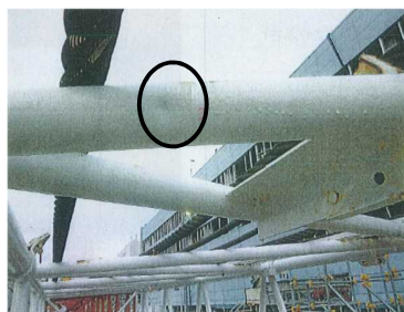
図2 750tクレーン（1号機） ジブ凹不具合
