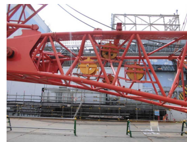
図3 800tクレーン ジブ損傷不具合
