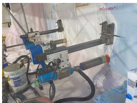
コア削孔装置設置状況
