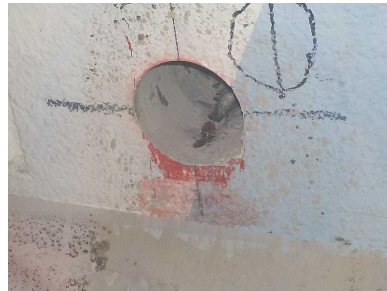
調査用コア採取の状況
