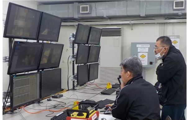
遠隔操作室 試運転状況
