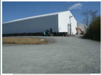
瓦礫保管テント
