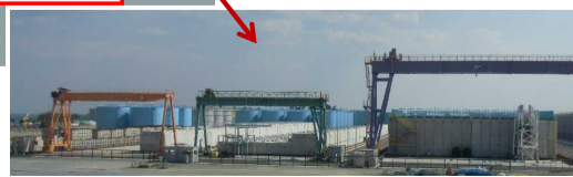
使用済吸着塔一時保管施設
