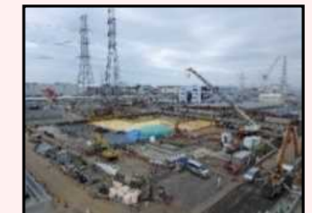
H1東エリア解体後の様子
