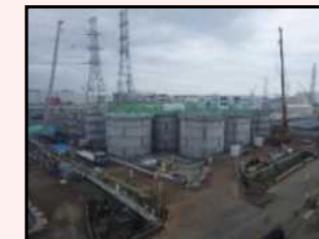
H1東エリア解体開始時の様子
