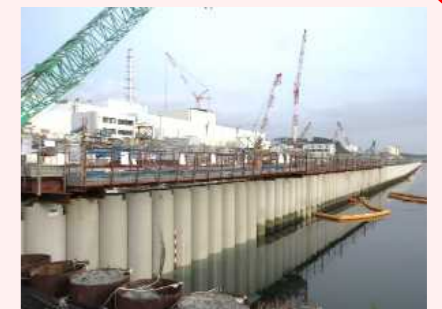
海側遮水壁 鋼管矢板打設完了状況
