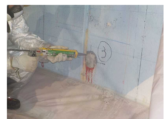
削孔箇所の孔塞ぎの状況
