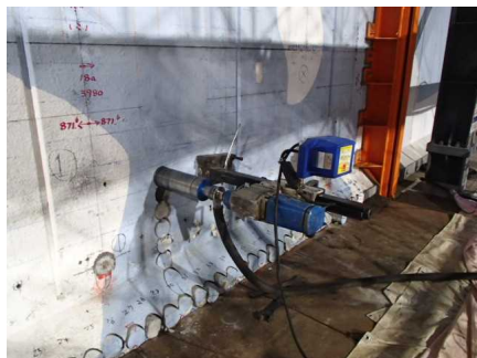
解体用コア削孔（STEP3） 2018/4/24撮影
