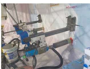
コア削孔装置設置状況
