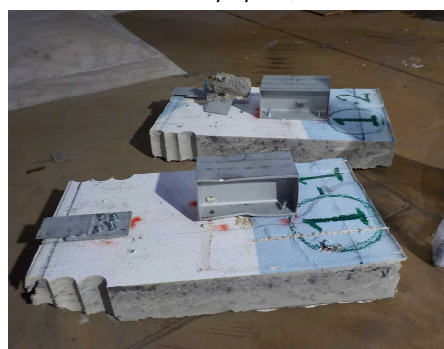
壁解体（STEP6） 2018/5/28撮影
