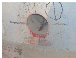
コアを削孔した状況
