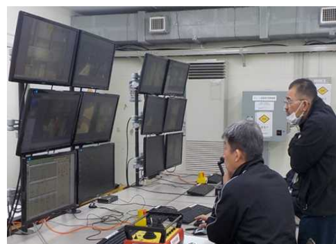
遠隔操作室 試運転状況
