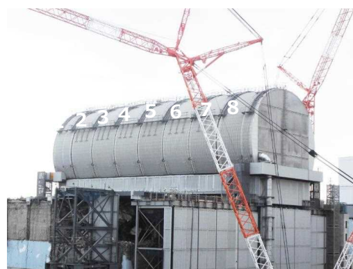
ドーム屋根設置完了
