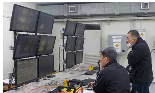
試運転実施状況（遠隔操作室）
