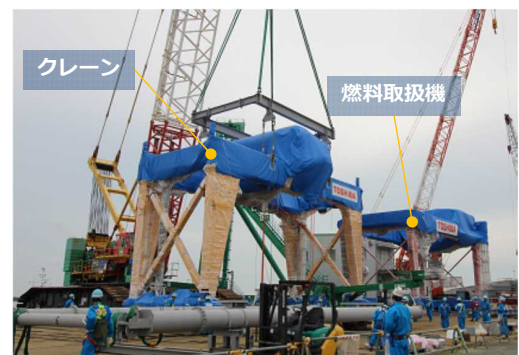
燃料取扱機・クレーンの海上から構内に搬入状況 (撮影日2017年11月8日)
