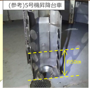
CRD交換機昇降台車にて、堆積物が埋まっていると見られる高さ
