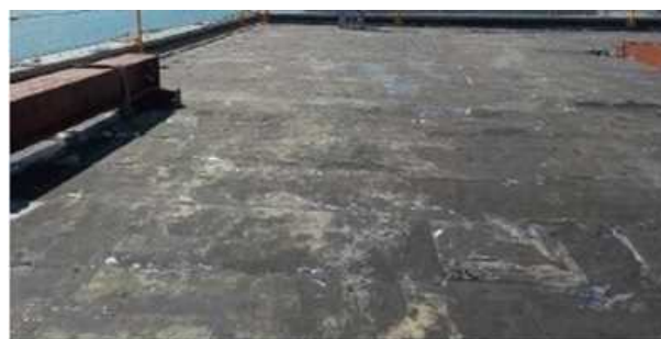
④作業完了状況
