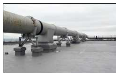
【現況】4号機T/B屋上 (本設防水完了)
