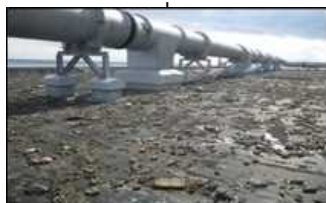
【施工前】4号機T/B屋
