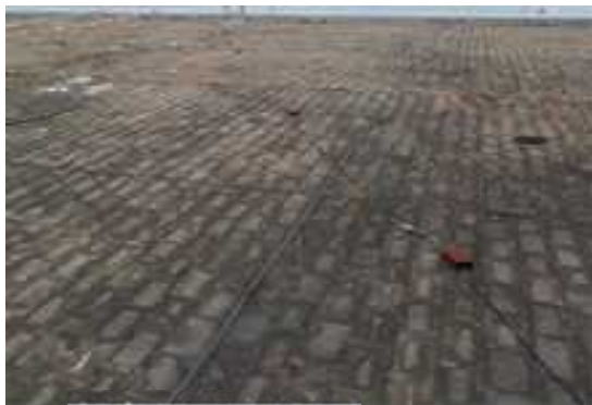
①作業前状況
