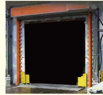
開口の設置状況
