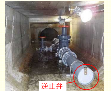
逆止弁の設置状況
