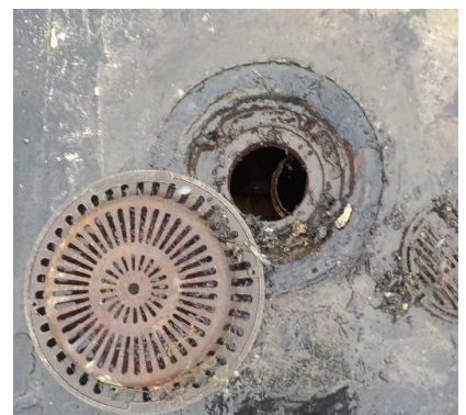
屋上ルーフトレン配管の損傷状況
