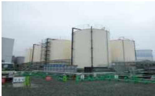
既設一時貯水タンク
