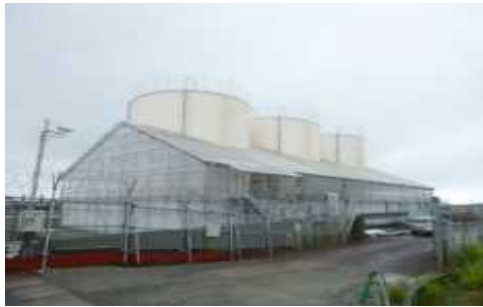
既設集水タンク
