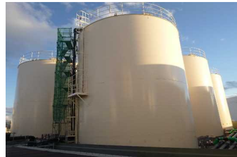
増設一時貯水タンク
