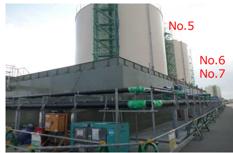
増設集水タンク
