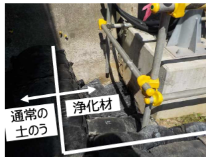
浄化材設置状況（1）
