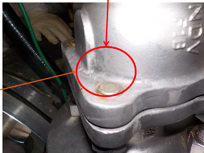
水ぬれ確認箇所
