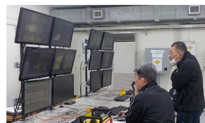
試運転実施状況（遠隔操作室）
