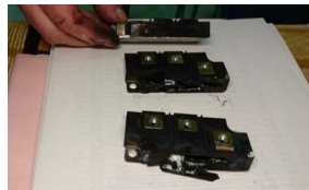
損傷の確認された整流器 (4月5日)
