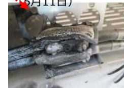
ブレーキレジスタ内の損傷 (5月12日)
