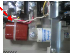
損傷の確認されたヒューズ (4月25日)
