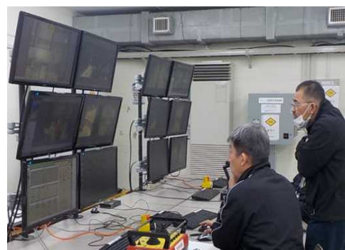
遠隔操作室 試運転状況
