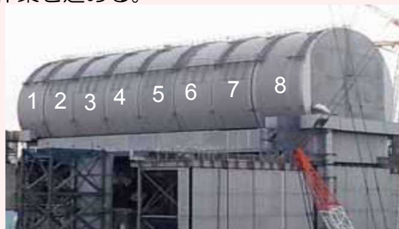
ドーム屋根設置状況(2/21撮影)
