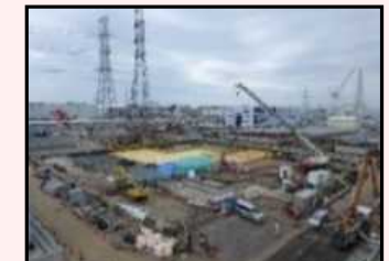
H1東エリア解体後の様子
