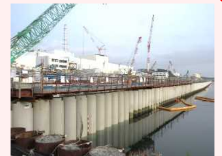
海側遮水壁 鋼管矢板打設完了状況
