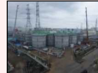
H1東エリア解体開始時の様子
