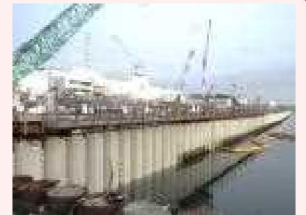
海側遮水壁 鋼管矢板打設完了状況
