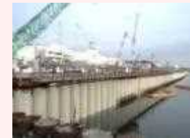
海側遮水壁 鋼管矢板打設完了状況
