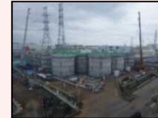
H1東エリア解体開始時の様子
