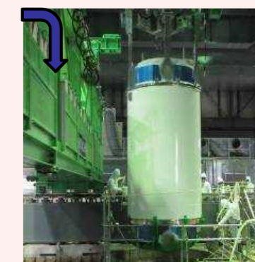
燃料取り出し状況
