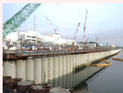
海側遮水壁 鋼管矢板打設完了状況
