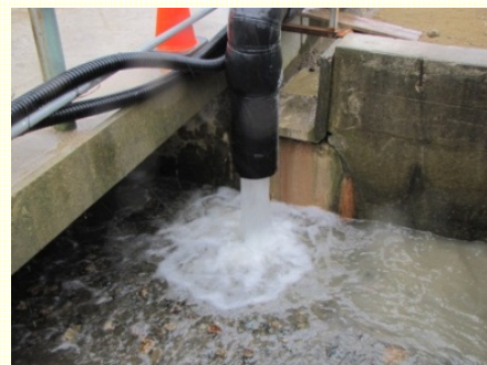
＜地下水バイパス 排水状況＞
