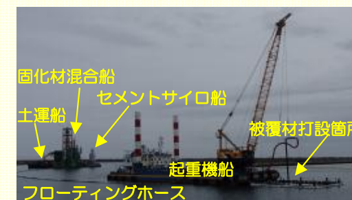
<港湾内被覆作業の様子>
