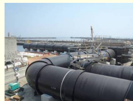
<配水管設置状況>
