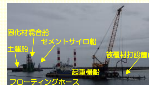
<港湾内被覆作業の様子>
