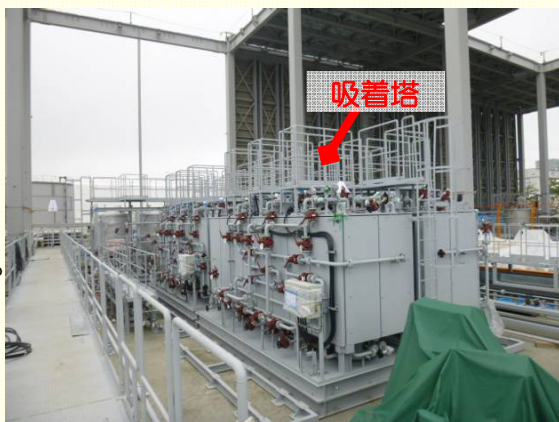
<増設多核種除去設備 設置状況>
