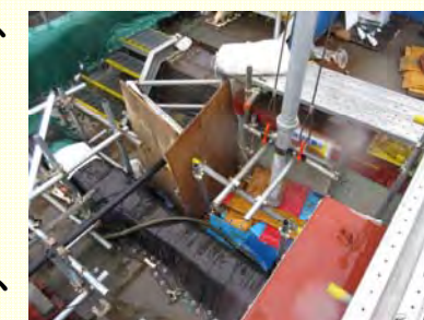
<充填孔付近の様子>
